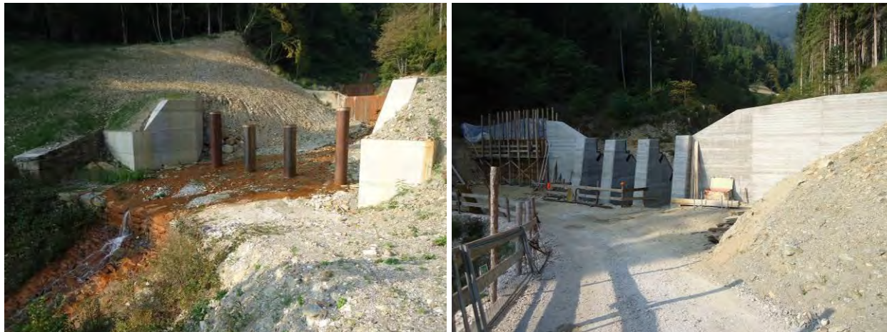
Figg. 8.1.10-8.1.11- Opere filtranti realizzate recentemente a quota 740 e 705 m slm
