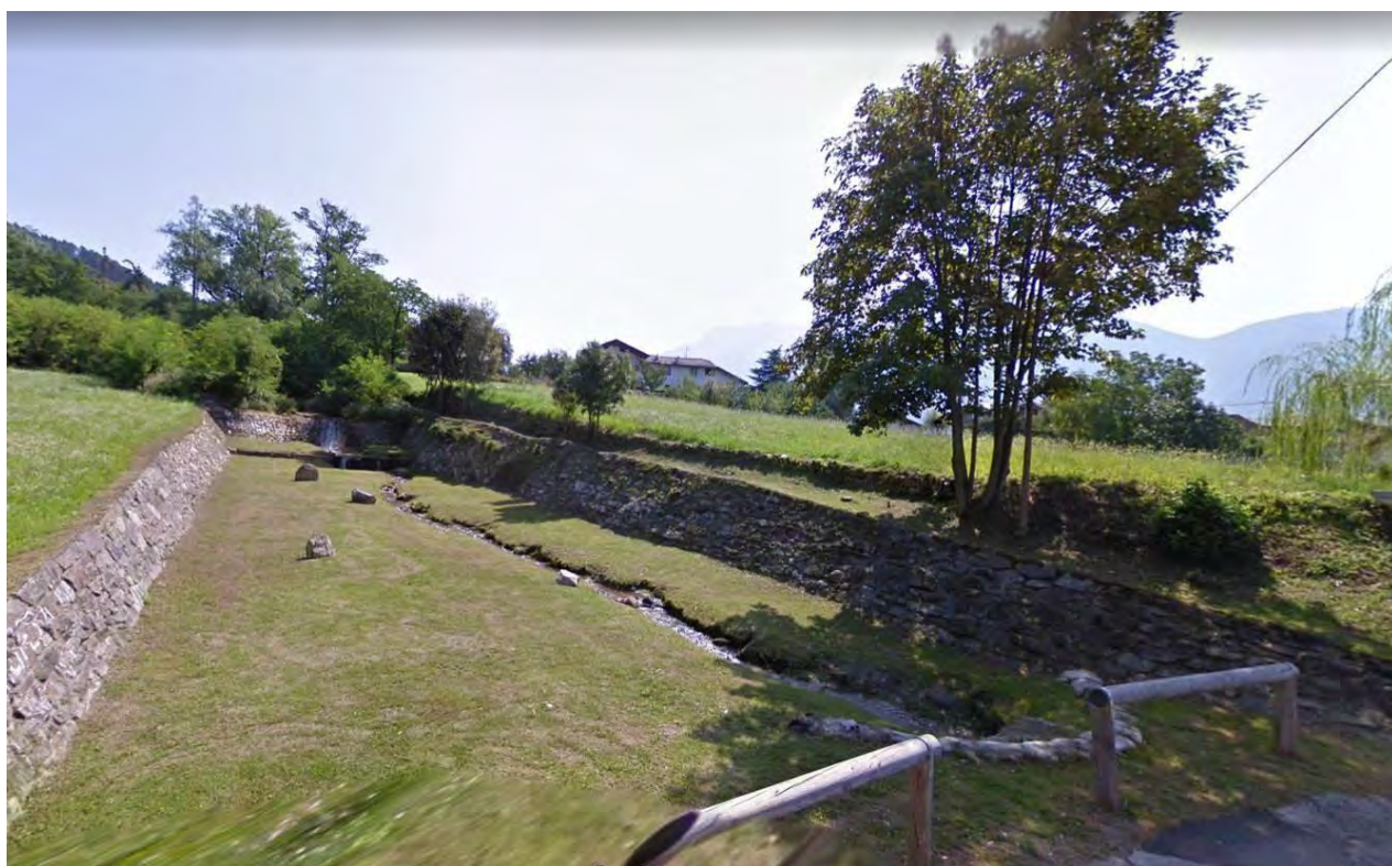
Fig. 8.2.5-8.2.6 – Configurazione attuale del tratto d'alveo oggetto di verifica: l'attuale attraversamento avviene con una tubatura assolutamente sottodimensionata per smaltire le portate più temibili provenienti dal bacino.
