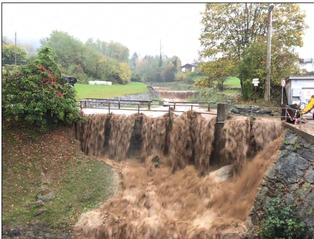
Foto 1.1 – il guado di Via Salina durante l'evento VAIA è risultato insufficiente a contenere la portata del corso d'acqua
